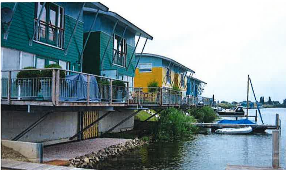
▲ Maison amphibies réalisées entre 1998 et 2005 par le gouvernement des Pays Bas à Maarsbommel. Le quartier est constitué de 32 maisons amphibies et de 14 maisons flottantes. Les maisons amphibies ont été construites par paire pour augmenter leur résistance aux vagues. Elles coulissent le long d'un même pylône. Une inondation en 2011 a démontré le bon fonctionnement de ce système.
