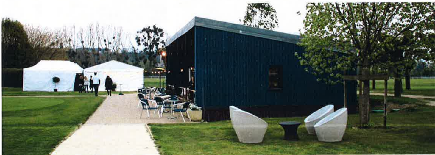
▲ Club House du golf de Maisons Laffitte. Le golf a été inondé en 2016. Le club house a flotté et n'a pas subi de dégâts. (Architecte : Berthel, conception des flotteurs : Batiflo)
