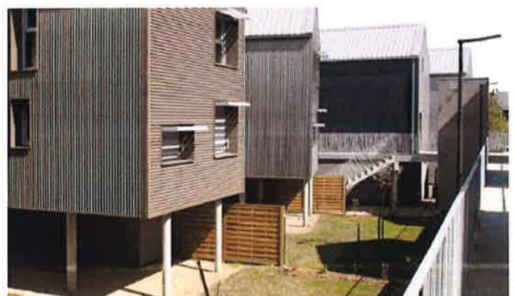
▲ Protection _ S'affranchir du sol Opération Nouvelle, Saint-Pierre-des-Corps, Atelier Gaurdon
