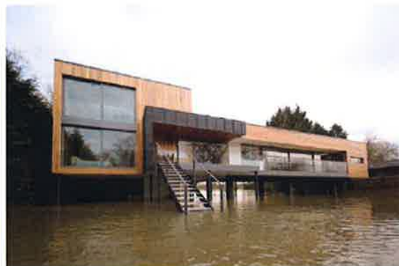
▲ Maison sur pilotis construite en 2008 dans le but de résister aux crues saisonnières de la rivière située en contre bas. L'espace protégé au sol est utilisé comme parking pour les voitures. Hind House, Angleterre – John Pardey Architects
