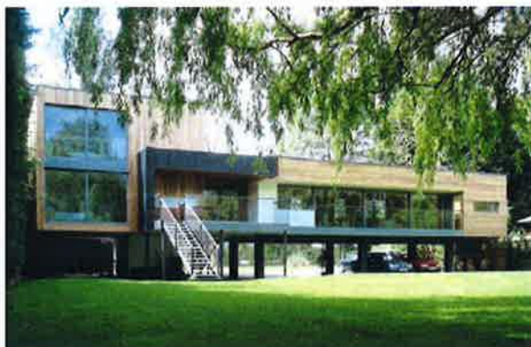
▲ Maison sur pilotis construite en 2008 dans le but de résister aux crues saisonnières de la rivière située en contre bas. L'espace protégé au sol est utilisé comme parking pour les voitures. Hind House, Angleterre – John Pardey Architects
