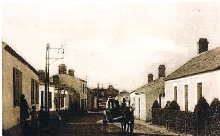
Habitat de village, La rue de la Poste
