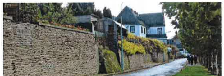
▲ Protection _ Aménager en intégrant les ouvrages de lutte contre la submersion (Digue, Leutesdorf)
