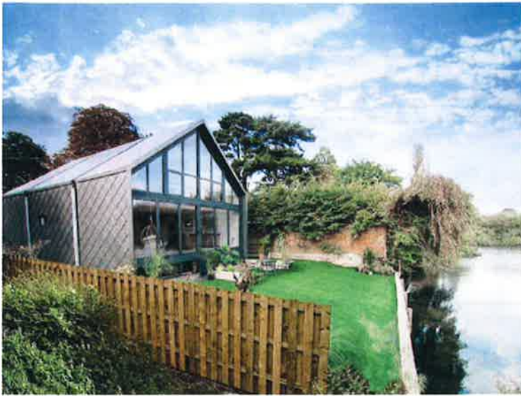
▲ Première maison amphibie de Grande-Bretagne, conçue par l'agence BACA, basée à Londres. Elle est construite dans une cale en béton (coulé sur place), dite « cale humide » et est constituée en partie basse d'un coisson vide en béton permettant à la maison de flotter (préfabriqué en usine). Lors d'inondations, l'eau entre dans la cale et soulève la maison guidée par quatre poteaux en acier (jusqu'à 2,70 m de haut). La partie haute de la maison (hors d'eau) est constituée d'une structure légère en bois. La maison reste fonctionnelle durant le temps de l'inondation grâce à des gaines électriques et de réseaux d'eau flexibles qui peuvent s'allonger de 3m. Pour des raisons de sécurité le gaz est proscrit. Le jardin a été pensé dans le but d'alerter les habitants de l'arrivée d'une crue.
