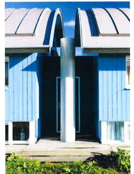
▲ Maison amphibies réalisées entre 1998 et 2005 par le gouvernement des Pays Bas à Maarsbommel. Le quartier est constitué de 32 maisons amphibies et de 14 maisons flottantes. Les maisons amphibies ont été construites par paire pour augmenter leur résistance aux vagues. Elles coulissent le long d'un même pylône. Une inondation en 2011 a démontré le bon fonctionnement de ce système.
