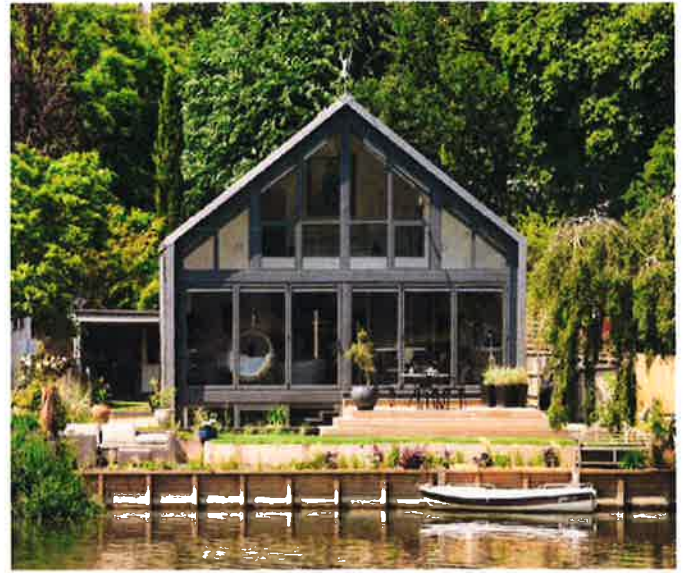
▲ Première maison amphibie de Grande-Bretagne, conçue par l'agence BACA, basée à Londres. Elle est construite dans une cale en béton (coulé sur place), dite « cale humide » et est constituée en partie basse d'un coisson vide en béton permettant à la maison de flotter (préfabriqué en usine). Lors d'inondations, l'eau entre dans la cale et soulève la maison guidée par quatre poteaux en acier (jusqu'à 2,70 m de haut). La partie haute de la maison (hors d'eau) est constituée d'une structure légère en bois. La maison reste fonctionnelle durant le temps de l'inondation grâce à des gaines électriques et de réseaux d'eau flexibles qui peuvent s'allonger de 3m. Pour des raisons de sécurité le gaz est proscrit. Le jardin a été pensé dans le but d'alerter les habitants de l'arrivée d'une crue.
