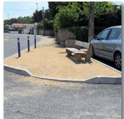
Aménagement d'un parking aux Ilettes
