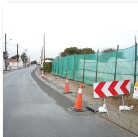
Réfection des trottoirs rue de la Poste
