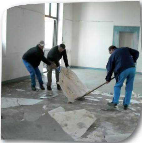
Réhabilitation de la Salle Océane
