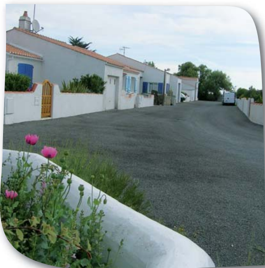
Réfection de la rue des Bleuets
