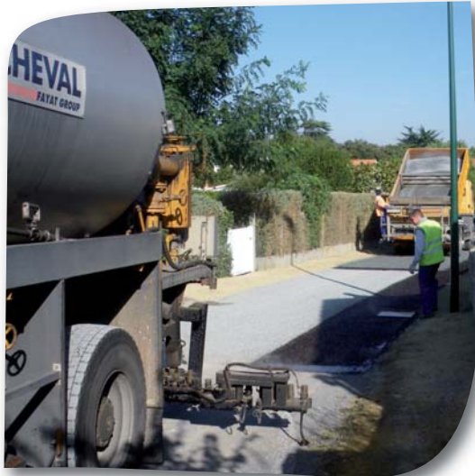
Effacement de réseaux rue de la Frandière
