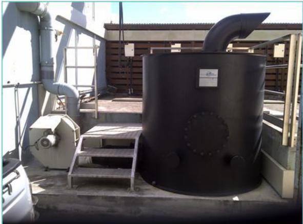
Ce principe de traitement peut s'appliquer à certains regards de réseau d'assainissement. Il s'agit alors d'installer dans le regard un filtre au charbon actif de dimensions adaptées.
